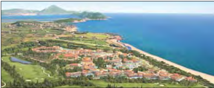
Das „Navarino-Resort“ hat eine der weitläufigsten KNX Installationen in Griechenland
