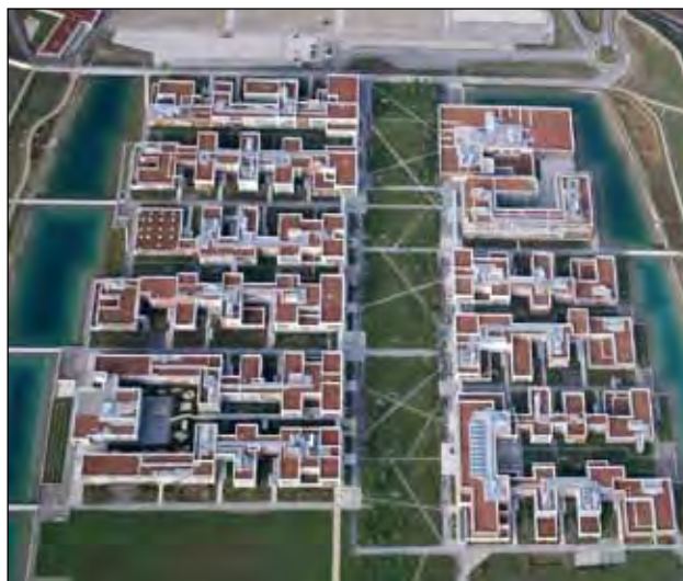
Sechs Server verbinden die KNX Welten entsprechend der Gebäudemodule für das Lichtmanagement.
